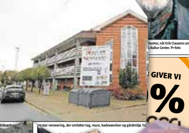
Renovering, der omfatter tag, mure, badværelser og gårdmål. Foto: Allan Mortensen
