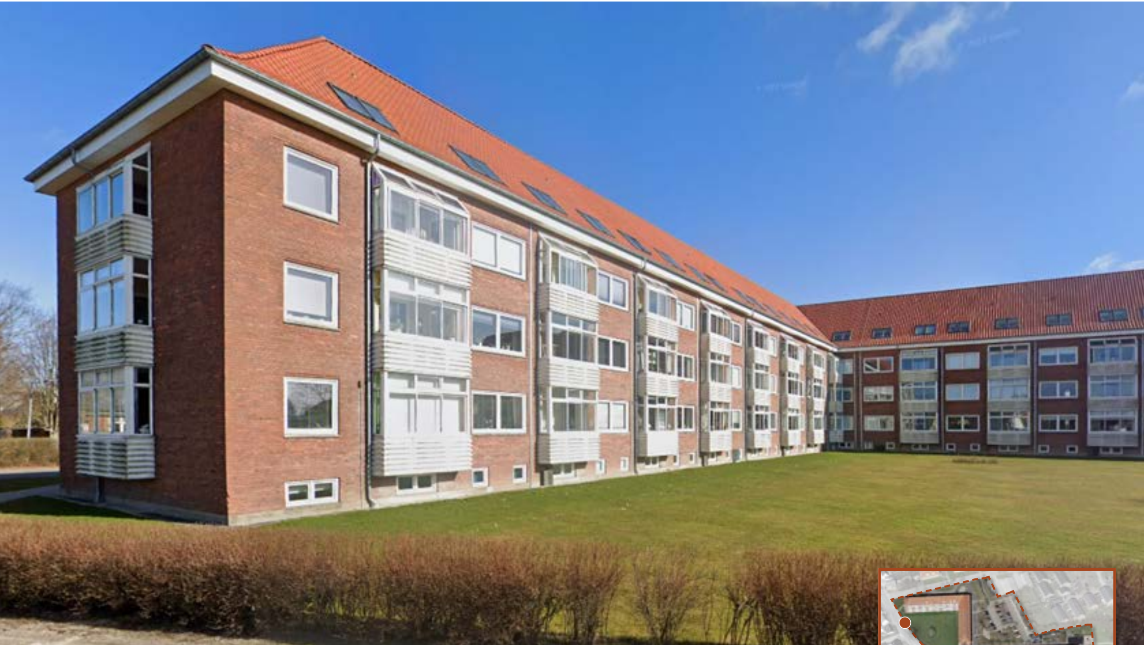
GAMMEL AFDELING 10 FACADER OG ALTANER EKSISTERENDE FORHOLD
