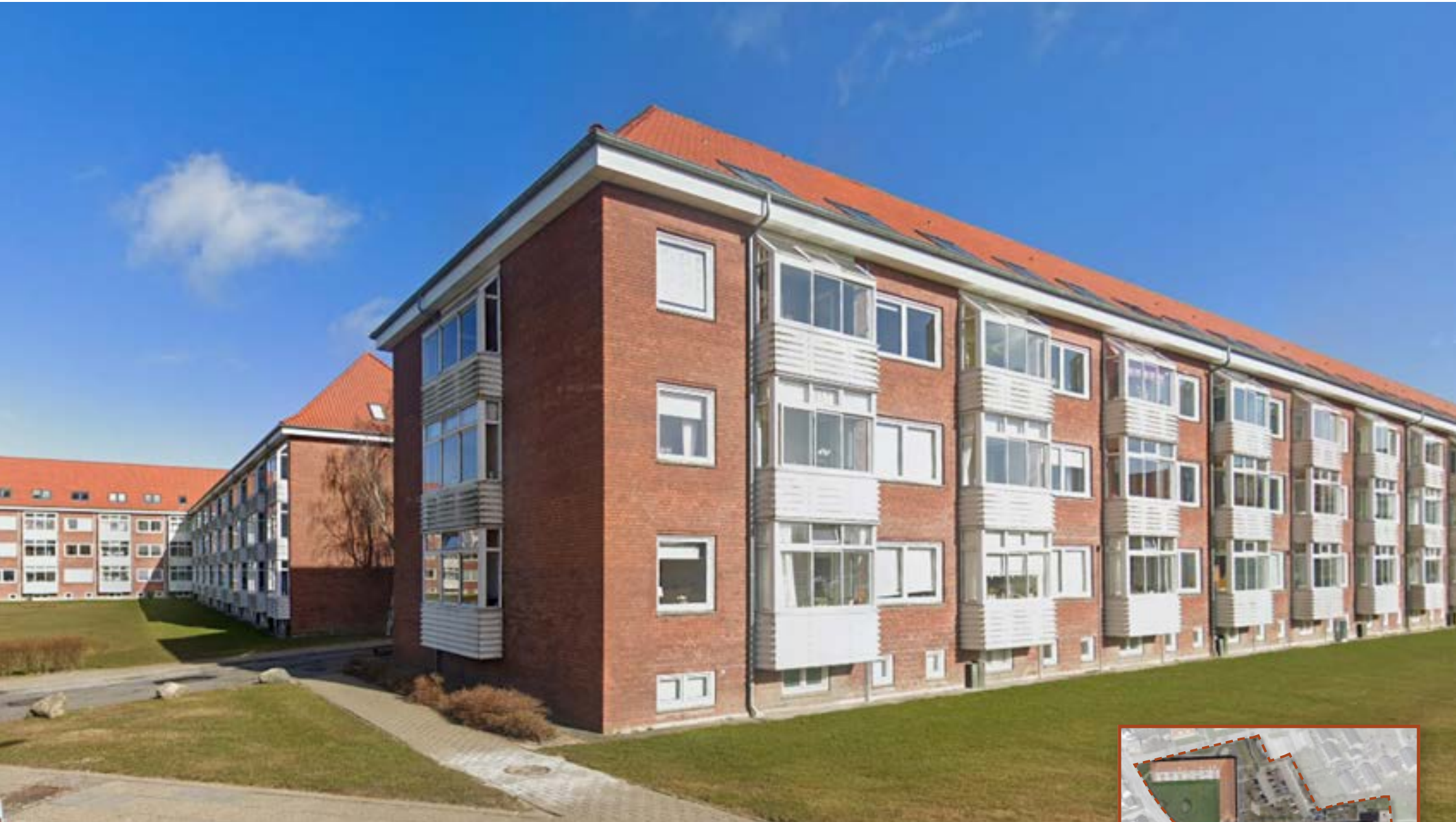
GAMMEL AFDELING 10 FACADER OG ALTANER EKSISTERENDE FORHOLD
