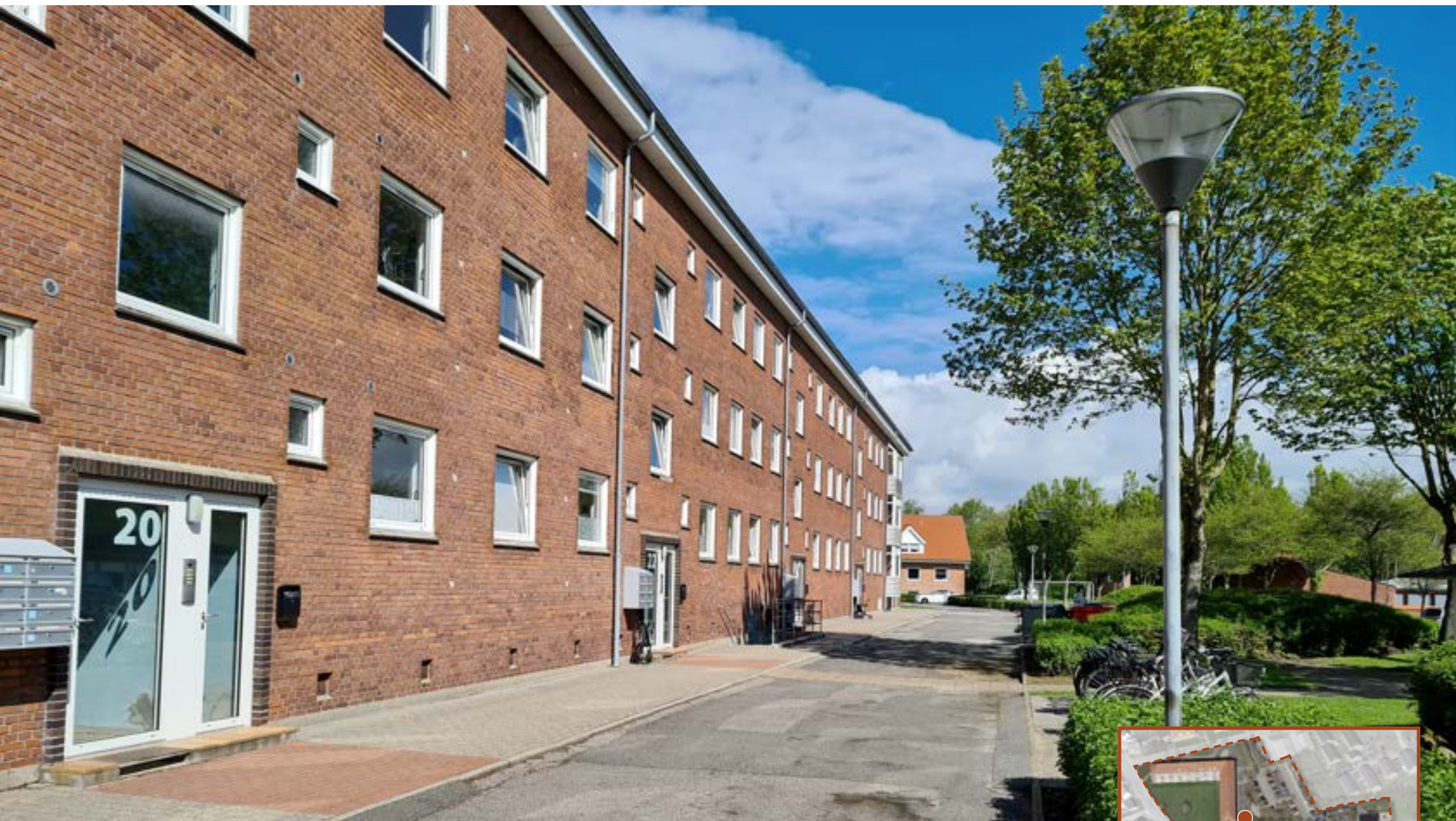
GAMMEL AFDELING 10 FACADER OG ALTANER EKSISTERENDE FORHOLD
