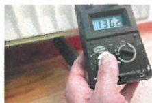
Nr. 38 fugt i facadevæg under vinduesparti.
