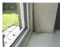
Nr. 18 Løst tapet i lysningen i stuen hvor der er udtøjet skimmelse, analyseret til kategori C (se bilag 2)
