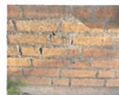
Eksempel på betydende nedbrydning i murets- gør
