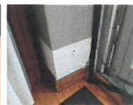
Nr. 24 Kviklæst tapet i lysning ved terrassedør, hvilket skaber oplygning.
